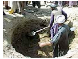
Erste Arbeiten; Ausheben der Zisterne.
